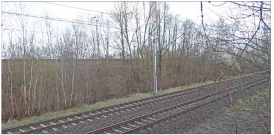
Dieses Bild vom März 2024 zeigt südlich der Abzweigung Biesdorfer Kreuz Südwest im Vordergrund das Gleis zur VnK-Strecke nach Rummelsburg und das Gleis zur Abzweigung Biesdorfer Kreuz Süd, wo es in den BAR nach Süden einmündet. Auf dem Bahndamm im Hintergrund verläuft der zweigleisige BAR. Durch die dazwischen liegende Senke ist ein neuer kurzer Bahndamm erforderlich, damit zukünftiger Fernverkehr aus Polen von der Ostbahn den BAR niveaugleich kreuzen und über die VnK-Strecke in Rummelsburg die Stadtbahn erreichen kann.
