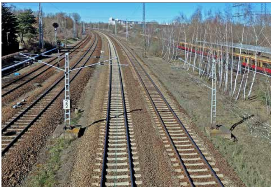
Das Bild vom April 2016 zeigt neben dem S-Bahn-Haltepunkt Gehrenseestraße von links nach rechts das Ausziehgleis des Rangierbahnhofs Berlin-Nordost, das Ein- und Ausfahr-gleis in diesen Bahnhof (der im Rücken des Fotografen liegt) und das Gleispaar des BAR. Hier sollen nach BSBB-Vorstellung die Gleise der NVT Ost niveaugleich nach Süden vom BAR abzweigen. Außerdem kann ein Wartegleis für die ausfädelnden Regio-S-Bahnen angeordnet werden. Ausreichend Platz ist vorhanden, auch für ein Überwerfungsbauwerk, falls dies bei steigendem Verkehr notwendig wird.
