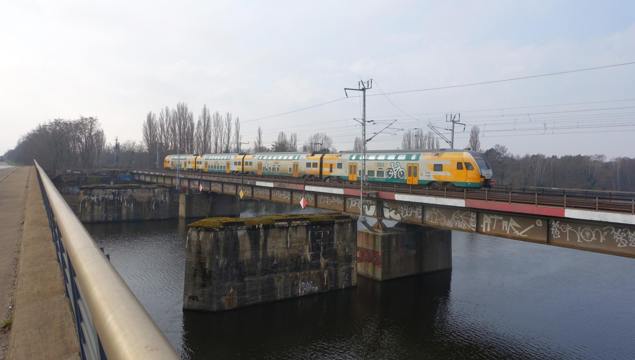
Östlicher Berliner Außenring ("BAR"), Blick auf die Spreebrücke, Richtung Süden. Östlich des vorhandenen Gleispaars ragen Strompfeiler und Widerlager für ein weiteres geplantes Gleispaar auf – für die seit den 1990er Jahren so genannte Nahverkehrstangente ("NVT"). Östlich daneben (auf dem Foto links) liegt die Wilhelm-Spindler-Straßenbrücke, bei deren Bau (2000 bis 2002) – und wie im FNP und im StEP Verkehr vorgegeben – die NVT-Trasse freigehalten wurde. Auch für einen Baukorridor wurde Platz gelassen. (Foto März 2024: BSBB)
