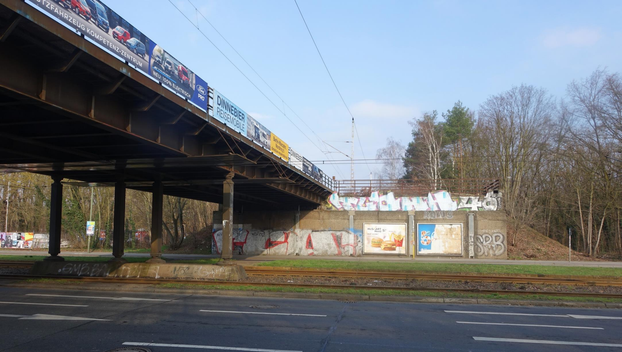
Eisenbahnüberführung des östlichen Berliner Außenrings über die Straße An der Wuhlheide, Blick auf das nördliche Widerlager. (Rechts hinter dem Fotografen kommt die Spindlersfelder Straße von der Wilhelm-Spindler-Brücke herab.) Deutlich zu erkennen ist das vorbereitete Widerlager für ein zweites Gleispaar, rechts daneben soll die TVO, die hier die Freihaltung Nahverkehrstangente berücksichtigt, in der Plus-1-Lage errichtet werden. (Foto März 2024: BSBB)
