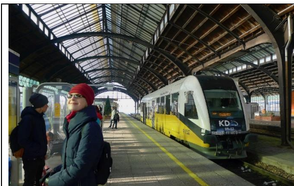
Abb. 11: Der Bahnhof Görlitz. Bis 2038 soll der elektrische Bahnbetrieb (15 kV/16,7 Hz, AC) Görlitz sowohl von Cottbus aus als auch von Dresden aus erreichen. Von polnischer Seite (3 kV DC) wird das in naher Zukunft geschehen.
