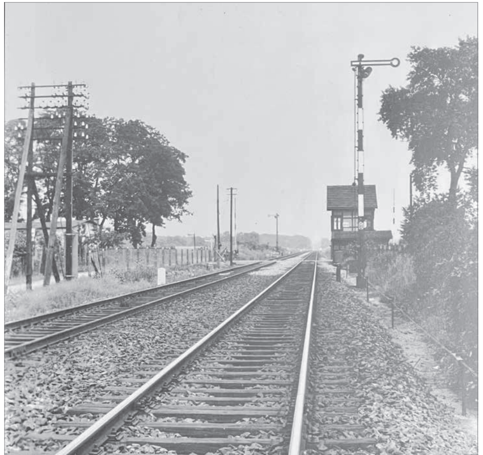
Stammbahn Berlin—Potsdam, Bahnübergang Benschallee in Düppel, 1935, vor Aufbau der Seitenbahnsteige. Auf der Strecke verkehrten u.a. die „Werderzüge“ vom/zum Potsdamer Bahnhof in Berlin (heute würde man sagen „Regionalverkehr“, künftig eventuell „Regio-S-Bahn“) mit Halt in Zehlendorf und Potsdam. Hier am rechten Formsignal erkennbar der Fahrsperrenschlag Bauart Berliner S-Bahn, mit dessen Gegenstück auch die Loks pr T 12 ausgestattet waren. Foto: RVM
