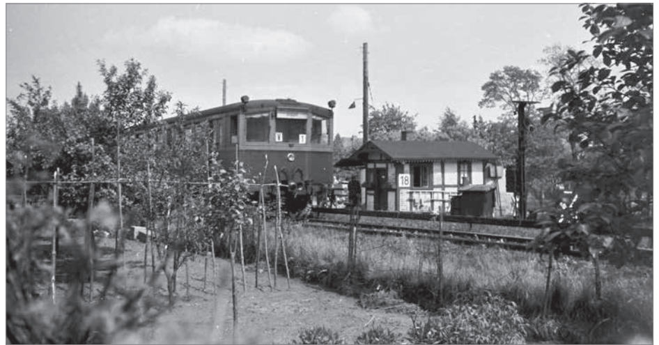
Ein S-Bahn-Viertelzug von Düppel nach Zehlendorf am Posten 18 der Stammbahn, dem Bedienplatz für die Schranke an der Clauerstraße. Foto (21.5.1962): Erhard Hübner-Kosney
