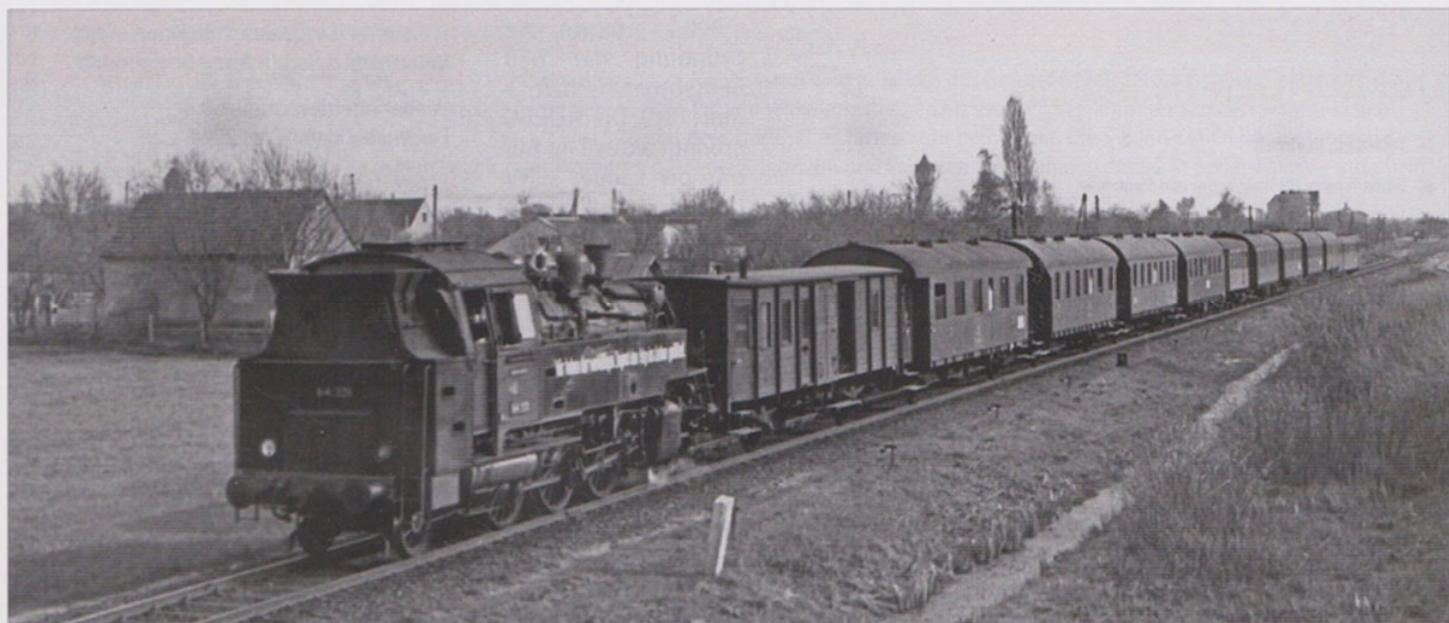
Foto eines „Heidekrautzugs“, aufgenommen von der Industriebahn-Trasse, die die Stammbahn in Hochlage kreuzt. Blickrichtung Süden, mit Siedlung Rosenthal und Rosenthaler Wasserturm (gesprengt 1958). Ganz rechts die Verbindungskurve ITF—Stammbahn. Die Länge des Personenzuges zeigt den damaligen Verkehrsbedarf zumindest in der Hauptverkehrszeit.
