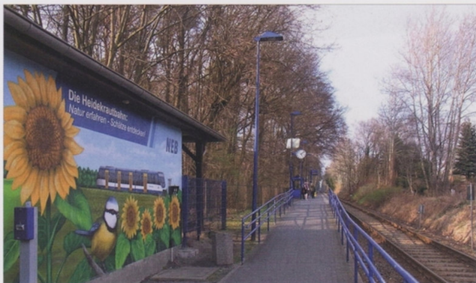
Der neue Bahnhof Schönwalde (Barnim) am Streckenast Basdorf—Berlin-Karow. Der alte Bahnhof Schönwalde an der Stammstrecke wird nach Wiedereröffnung zur Unterscheidung von Schönwalde (Barnim) Schönwalde West heißen, eine richtige Entscheidung. Foto: BSBB
