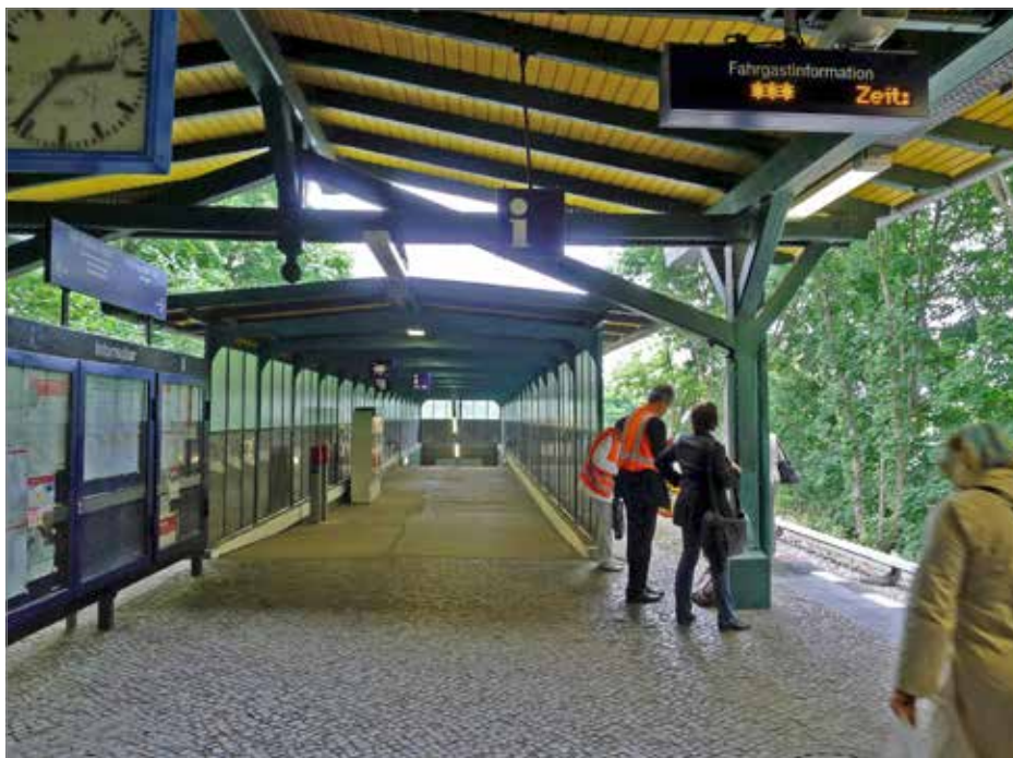
Beim S-Bahnhof Alt-Reinickendorf befindet sich der Durchstich des Zugangstunnels nach Norden, zur Flottenstraße, bereits in der Realisierung; die Inbetriebnahme ist für 2023 geplant. Beim Umbau des S-Bahnsteigs von 6- auf 8-Wagen Züge (siehe Tabelle auf Seite 26, lfd. Nr. 1) sollte auch zugleich die Einhausung des Zugangswegs auf der Bahnsteigebene verkürzt sowie die H-Tafeln für die Züge versetzt werden, sodass für die Fahrgäste ein kürzerer Zugangsweg entsteht.
