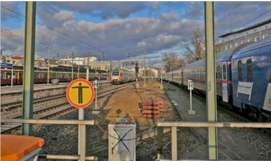
März 2022: Blick vom Regional-/Fernbahnsteig Gl. 1 und 2 nach Osten. In Blickrichtung könnte der Bahnsteig zur besseren Verkehrserschließung bis zum Zugangstunnel Gervinusstraße „verschoben“ werden. Auf Gleis 1 hat gerade Ausfahrt der in Charlottenburg beginnende NJ 457/40457 nach Wien/Budapest. Auf Gleis 3 nähert sich ein Triebzug der Linie RE 2, die leider in Charlottenburg grundsätzlich nicht hält. Fotos: BSBB
