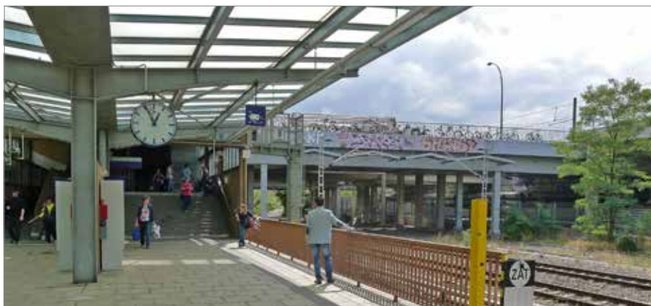
Am S-Bahnhof Landsberger Allee sollte durch Beseitigung von Absperrgittern der Bahnsteig um ca. 20 m nach Süden verlängert werden, um Fahrgästen den Zugangs- bzw. Umsteigeweg zur Straßenbahn um diese Länge zu verkürzen. Foto: BSBB
