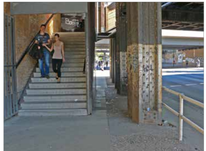
Beim S-Bahnhof Yorckstraße besteht seit Jahrzehnten dringender Handlungsbedarf: wie hier auf dem Foto erkennbar sind die Abmessungen sowohl für Fußweg als auch Fahrradweg absolut unzureichend; von Senat und der DB AG wurde bislang versäumt, entsprechende Umplanungen und deren Realisierung anzugehen.
