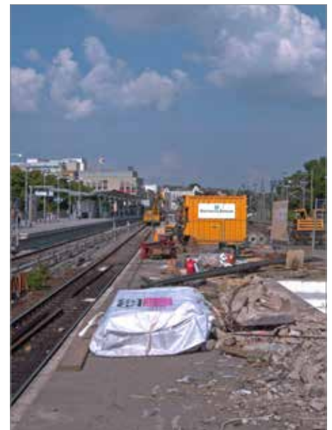
Die beiden S-Bahnsteige des Bahnhofs Charlottenburg wurden 2003 bis 2006 abgerissen und in neue Lage zur Wilmersdorfer Straße und der dortigen U-Bahn-Linie 7 „verschoben“. Im Foto von 2005 ist links der neue S-Bahnsteig, Gleis 7 und 8, bereits in Betrieb, rechts hat der Abbruch des S-Bahnsteigs Gleis 5 und 6 begonnen.
