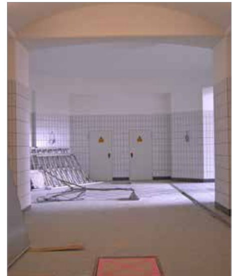
Der neue, östliche S-Bahn-Zugangstunnel des S-Bf Charlottenburg schließt nur das nördlich der Stadtbahn gelegene Gebiet an den S-Bahnhof an. Nach Süden, zur Gervinusstraße hin, wurde zwar eine Durchtrennungsmöglichkeit der Abschlusswand vorbereitet, aber bisher nicht realisiert. An diesen verlängerten Zugangstunnel sollten auch die beiden Regional-/Fernbahnsteige nach entsprechender „Verschiebung“ verkehrsgünstig angeschlossen werden.
