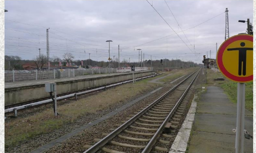
📍 Abb. 15: Görlitzer Bahn Richtung Süden. Rechts das südliche Ende des Hausbahnsteigs, Gleis 1. Links Gleis 2 der Gleichstrom-S-Bahn mit Gleisabschluss. Dahinter wiederum Gleise mit 15-kV-Oberleitung. Rechts von Gleis 1 schloss sich bis 1974 der Bahnsteig der Züge Richtung Mittenwalde und Töpchin und der Streckenabzweig an (vgl. Gleisplan in Abb. 3). Der Wiederaufbau sollte optional freigehalten werden.
