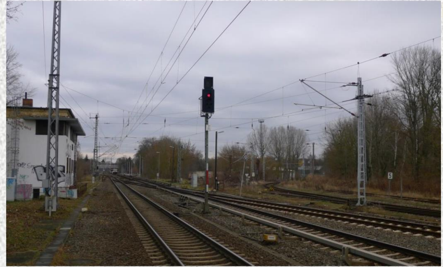
📍 Abb. 5: Blick vom Nordende des Hausbahnsteigs des Bf Königs Wusterhausen entlang der Görlitzer Bahn Richtung Norden. Im Hintergrund nähert sich ein S-Bahn-Zug der Linie S 46. Links das 2006 stillgelegte Stellwerk "Kwb", rechts die mit scharfer Kurve zum Hafen Königs Wusterhausen bzw. (mit Geschwindigkeitsbegrenzung "5" auf 50 km/h signalisierte) Strecke KW – Beeskow – Grunow. Die mit Wechselstrom-Fahrdraht überspannte Gleisverbindung zwischen Gleis 1 und Gleis 3 kreuzt das mit Gleichstrom-Stromschiene ausgerüstete Gleis 2. Die Kreuzung ist hier links vom Signal sichtbar.
