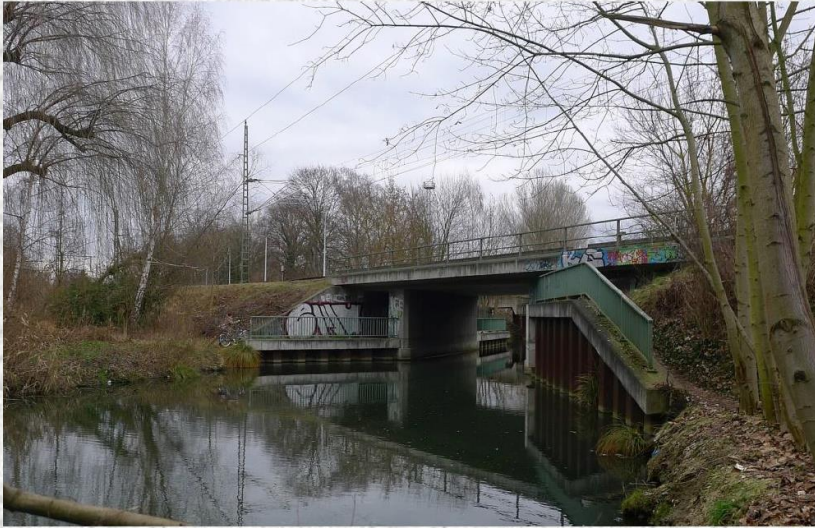
📍 Abb. 4: Nördlich des Bf Königs Wusterhausen (KW): Eisenbahn-Überführung der Görlitzer Bahn über den Nottekanal. Es werden zwei Gleise überführt (ehem. zwei Ferngleise, heute ein Wechselstrom- und ein Gleichstrom-Gleis).
