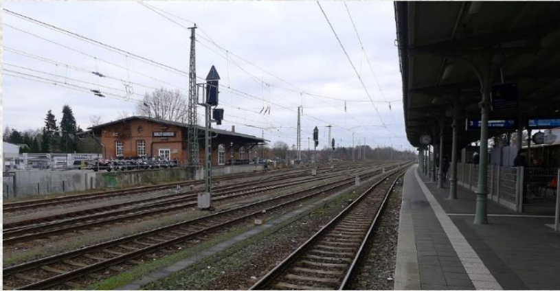
Abb. 12: Blick vom nördlichen Ende des Bahnsteigs Gleis 2/3 auf östliches Gleisfeld mit Streckengleis KW – Beeskow – Grunow, Gütergleise und ehemaligen Güterschuppen.
