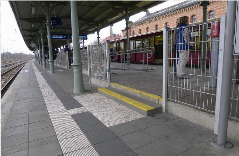
Abb. 10: Der Insel-Bahnsteig, Gleis 2 (rechts, mit Gleichstrom-S-Bahn; 103 cm ü SO) und Gleis 3 (links, mit 15-kV-Oberleitung; für Regionalverkehr; 76 cm), ist mit Absperrgittern längsgeteilt. An Öffnungen wurden zur Überwindung des Höhenunterschieds Rampen bzw. Treppenstufen angelegt.
