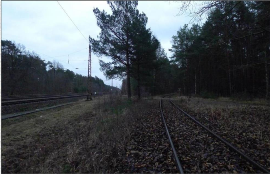
Abb. 21: Westliches Ende der Überholgleise (links), Blick nach Osten. Rechts das zum/vom GVZ Freienbrink führende Streckengleis. Der beiderseits dieses Gleises angrenzende Wald wird für die Tesla-Fabrik gerodet werden.
