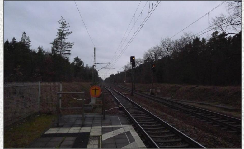
Abb. 20: Westliches Bahnsteigende des Bf Fangschleuse, mit Blick auf die Weichen für die weiter westlich liegenden Überholgleise.
