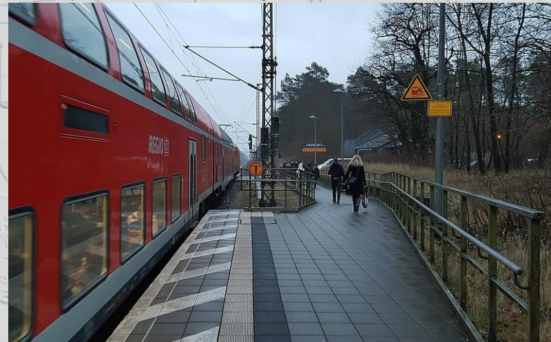
📍 Rampe vom südlichen Bahnsteig zur L 23
