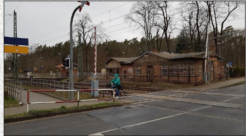
Abb. 16: Bahnübergang der Landesstraße L 23 am Bahnhof Fangschleuse (Ost-Ende). Rechts das nicht mehr in Betrieb befindliche und (ähnlich wie das dahinter liegende Bahnhofsrestaurant "Waldschänke") dringend sanierungsbedürftige Empfangsgebäude.
