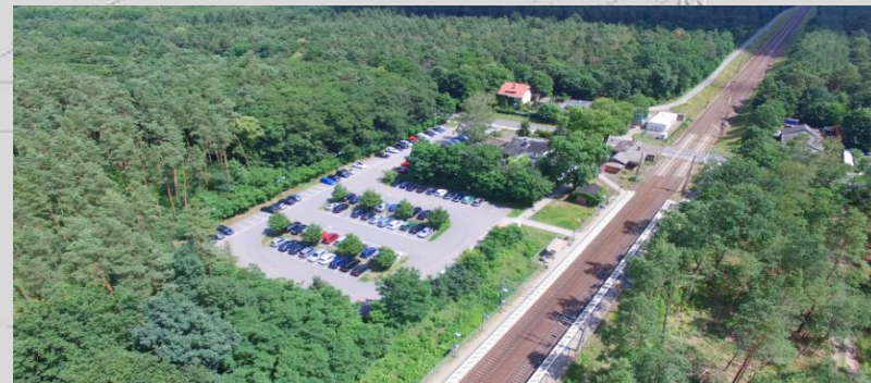
📍 Bf Fangschleuse; Luftbild östlicher Teil mit P+R-Platz und L 23
