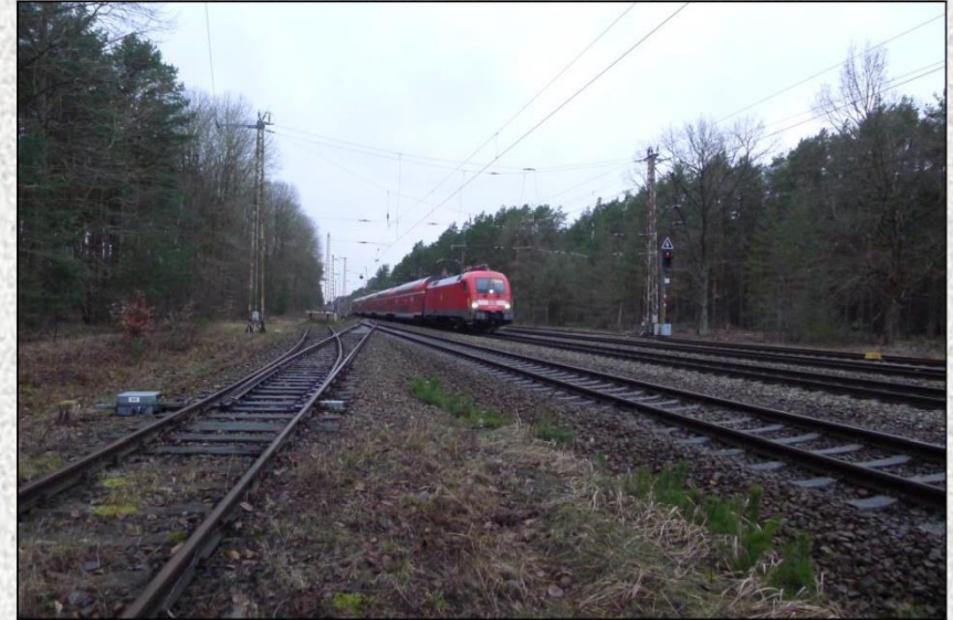
Abb. 22: Streckengleise der Frankfurter Bahn mit Zug der Linie RE 1, Magdeburg – Berlin – Frankfurt (Oder), und westliches Ende der Überholgleise. Links Einmündung des vom GVZ Freienbrink ankommenden Streckengleises (mit Flankenschutzweiche und Gleisabschluss). Blick nach Westen. Der links angrenzende Wald wird für die Tesla-Fabrik gerodet werden.
