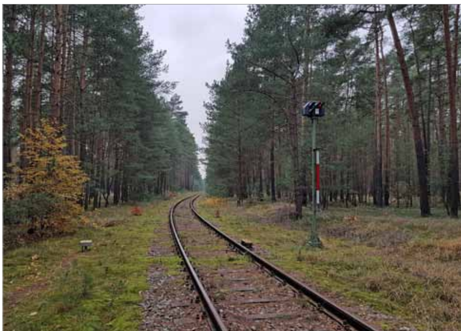
Gleis zum Güterverkehrszentrum Freienbrink auf dem künftigen Tesla-Werksgelände.
